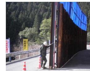
現場で発生した丸太材を防護柵のクッション材に使用
