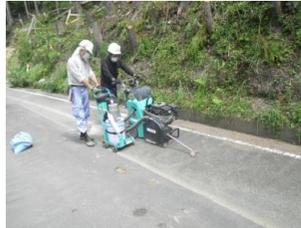
舗装切断時における粉塵の回収（乾式型使用）
