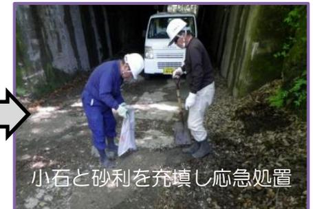
小石と砂利を充填し応急処置
