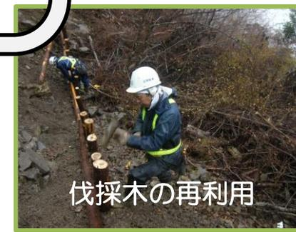
工事で支障となる立木は伐採して防護柵等に利用し、根株は自走式リサイクル機械を用いて粉碎（チップ加工）し、構造物の埋戻し材・マルチング材として利用しました。
