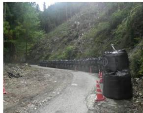
山腹崩壊斜面に耐候性土嚢を使用
