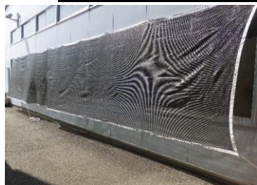
遮光カーテン設置
