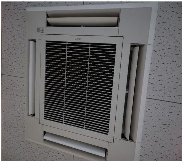
【省エネエアコン設置】
