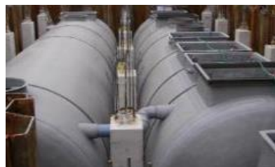
合併浄化槽
