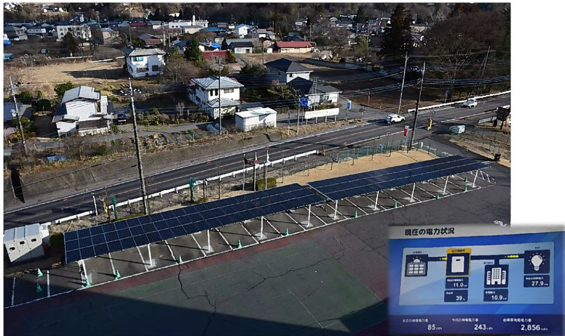
本社内 発電電力自家消費型ソーラーパネル 2023年1月竣工
