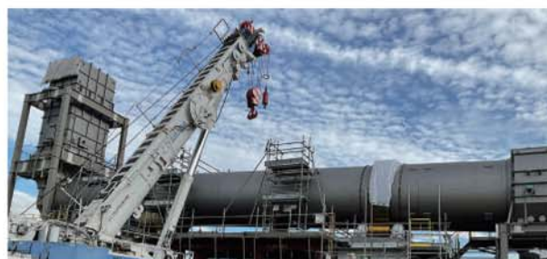
建設中の様子
