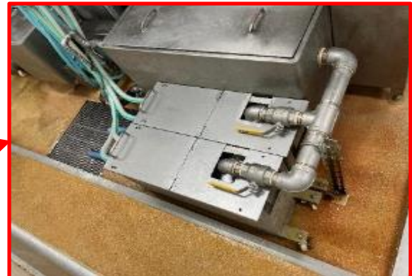
熱回収装置設置状況
