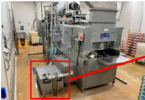
熱回収装置設置状況
