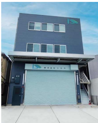
2022年11月に東大阪倉庫が完成
