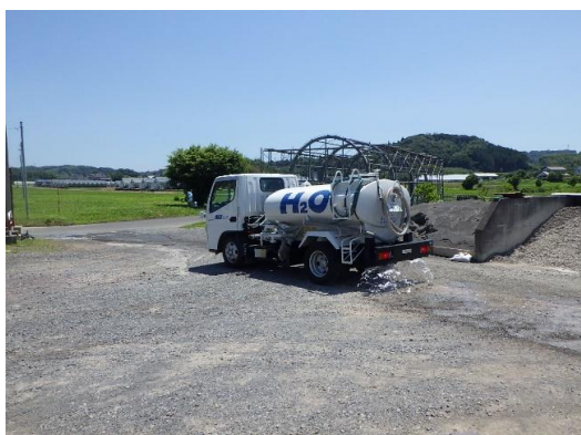
散水車による砂埃防止
