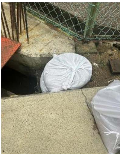
排水溝からの油分・汚水流出防止に土嚢袋を設置
