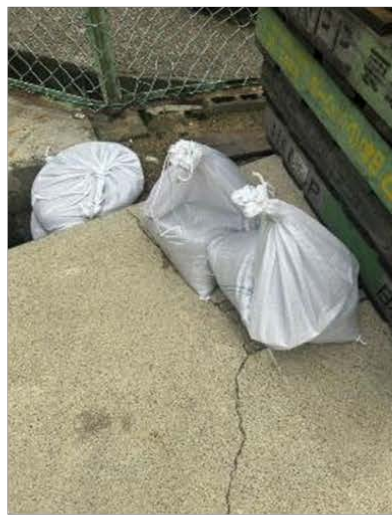
排水溝からの油分・汚水流出防止に土嚢袋を設置
