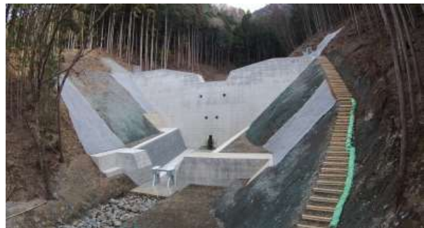
砂防堰堤工事
