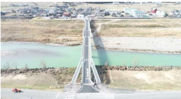
橋耐震・補修工事
