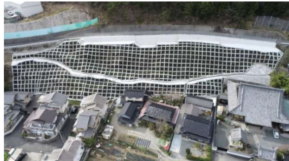
急傾斜地崩壊防止工事
