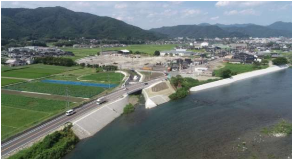
道路改良工事
