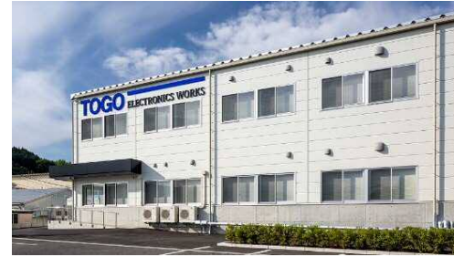
株式会社東郷電機製作所 本社工場 鳥取県東伯郡湯梨浜町門田906-1
