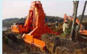
大型重機45tの稼働状況
