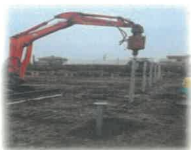
g.太陽光発電・基礎工事(特許工法)
