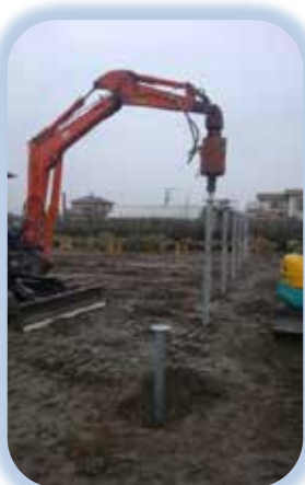
ネジ杭工法(太陽光発電基礎工事)
