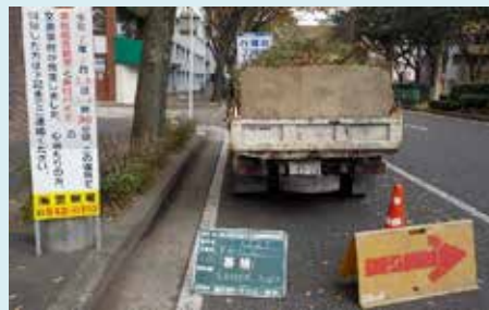
現場剪定クズの運搬状況
