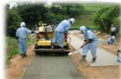
h.透水性舗装工事(占有特許工法)
