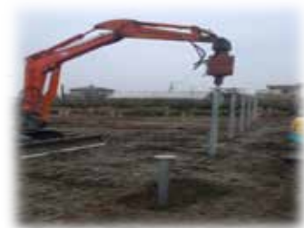
g.太陽光発電・基礎工事(特許工法)
