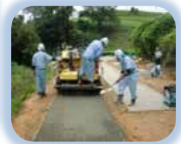
透水性保水型舗装(ATTAC工法)
