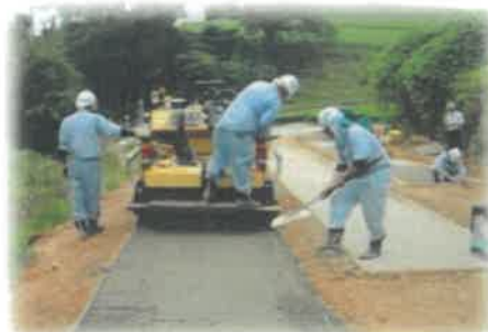
h.透水性舗装工事(占有特許工法)
