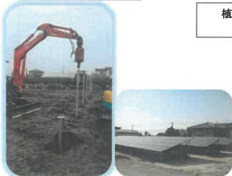
ネジ杭工法(太陽光発電基礎工事)
