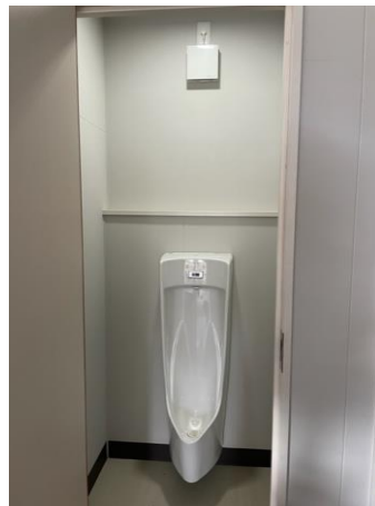
小便器の新規設置
