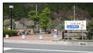
公園の景観に配慮口
