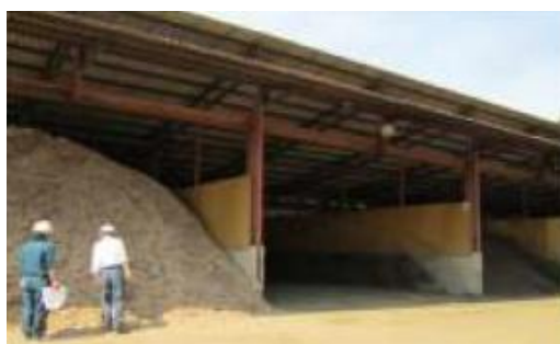
木材チップ保管施設
