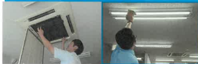
空調機器の清掃
