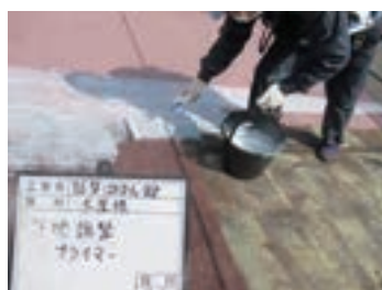
プライマー塗布
