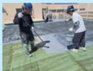
屋上駐車場防水工事
