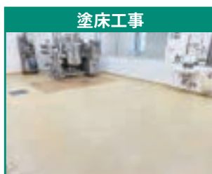
塗床工事 環境に配慮した工事 (HACCP 対応)
