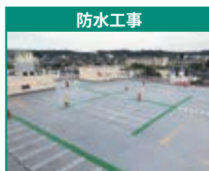
防水工事 環境に配慮した工事 (TX フリー)
