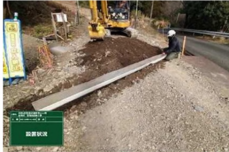
横断ベルトの設置
