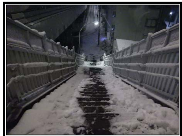
総武陸橋（江戸川区内） 除雪作業完了
