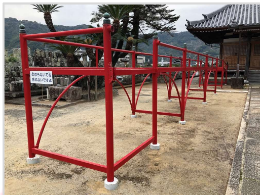
常設されていた架台
