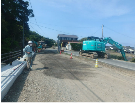
粉塵対策(散水)
