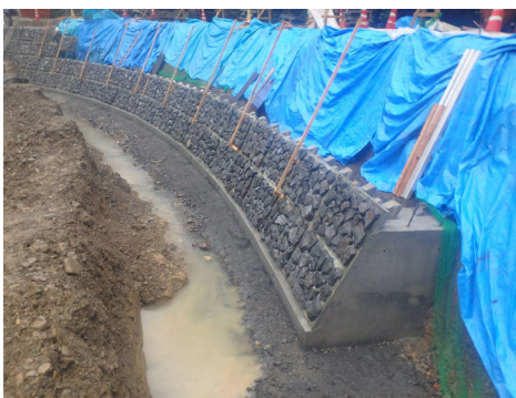
濁水流出対策(土砂部シート養生)
