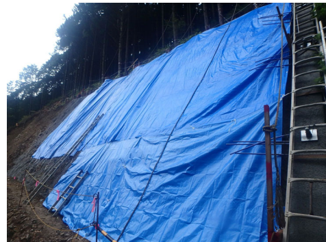
濁水流出対策(土砂部シート養生)
