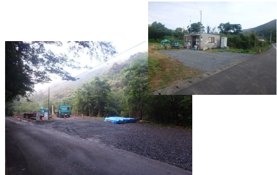
粉塵対策(車両出入口 単粒碎石を敷均し)
