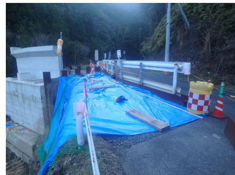
濁水流出対策(土砂部シート養生)
