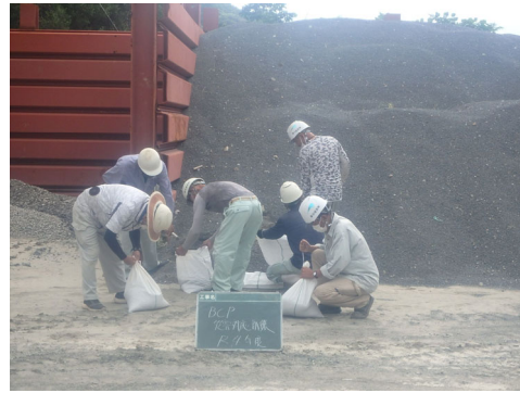
緊急時対応:土のう製作訓練
