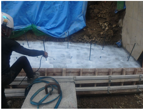
環境配慮:新技術活用 (レイタンス処理液の流出排除)
