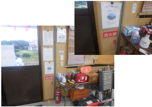
緊急時対応:消火設備 (環境レポート配布・各手順書 掲示)
