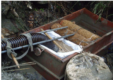
濁水流出対策(環境配慮型濁水処理設置)
