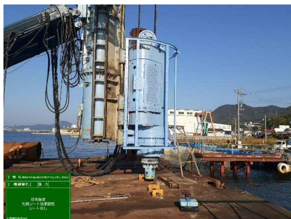
防音シート装着前
