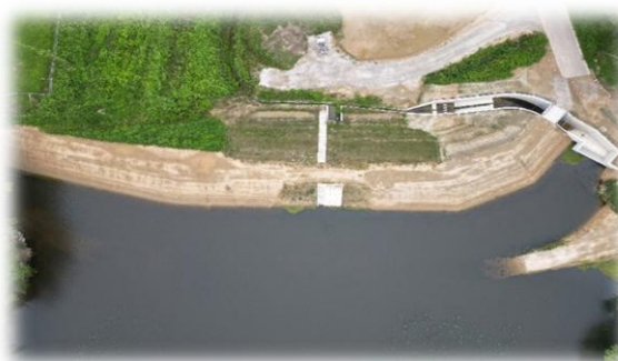
高丸池地区 高丸池改修工事（その2）
