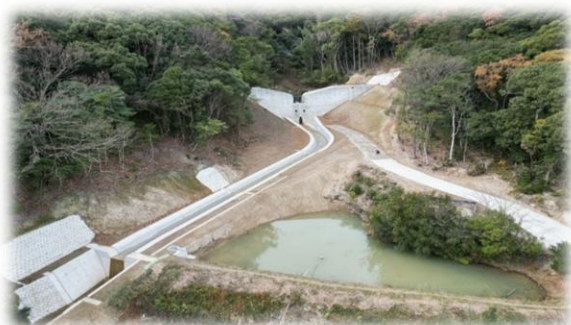
三宅川他流路工設置工事
