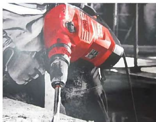
集塵ドリル使用
