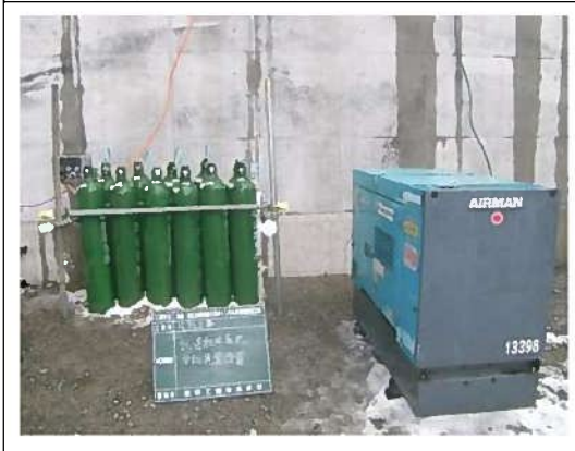
現場内排水処理(湧水pH処理)
