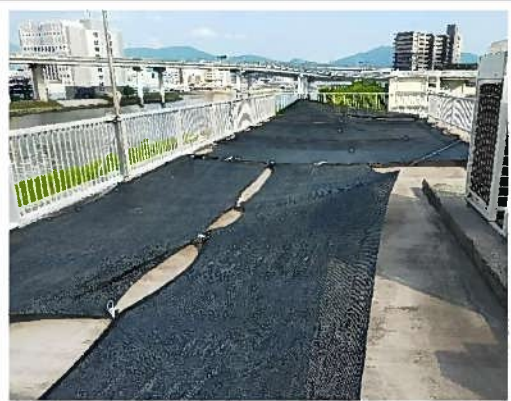
屋上遮光シート設置
