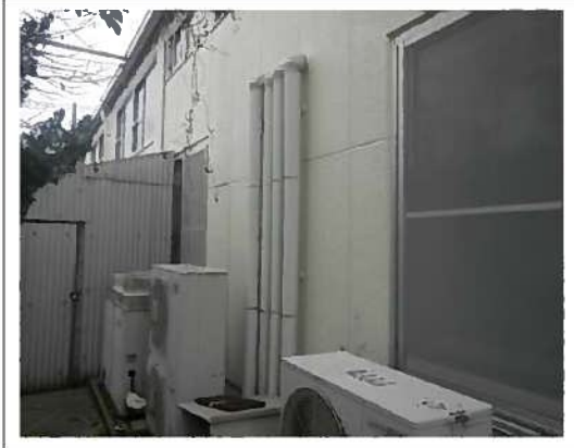
施工面での機種選定
