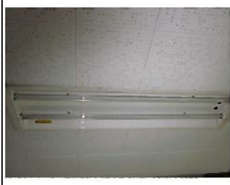
LED照明の導入
