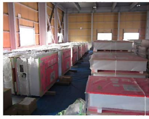
資材保管場所(工程管理)
