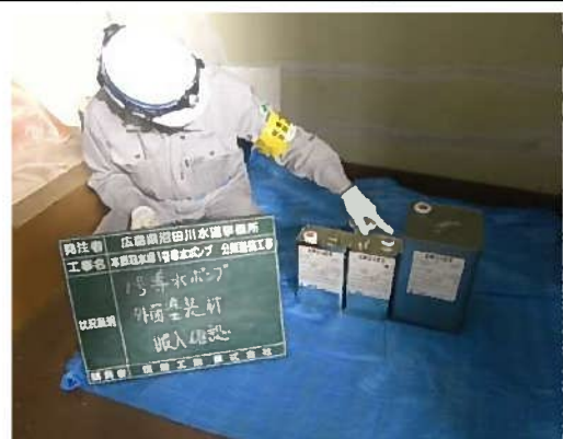
ノンタールエポキシ樹脂塗料使用
