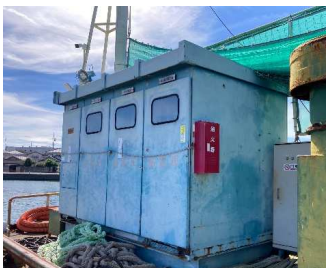
高圧改修工事(塩害地域) 更新前
