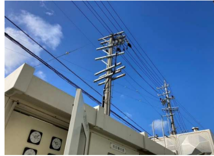
高圧設備取替修繕
