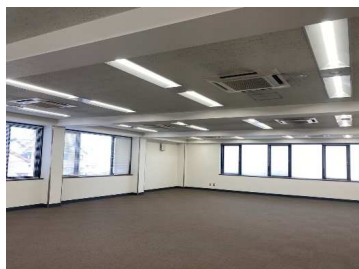
事務所ビルLED化、高圧改修工事
