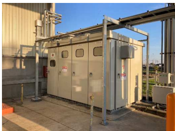
水産会社高圧改修工事
