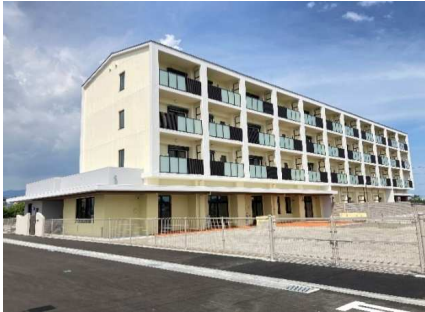
病院宿舍建設工事
