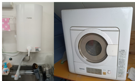
LPGから電気式になった給湯器と乾燥機
