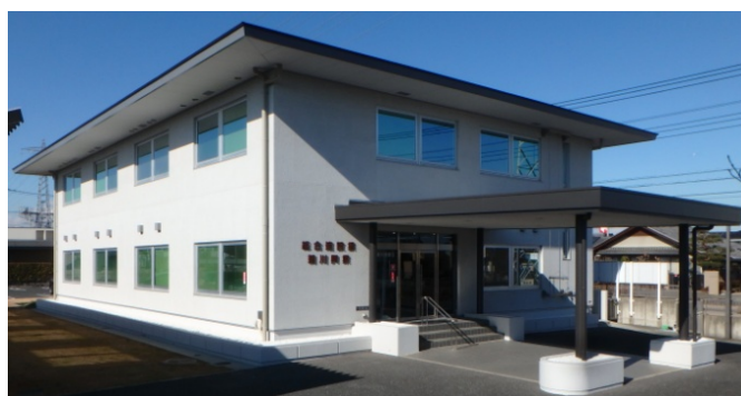
機械換気用吸排気孔が軒天と壁に見える 2021年01月撮影
