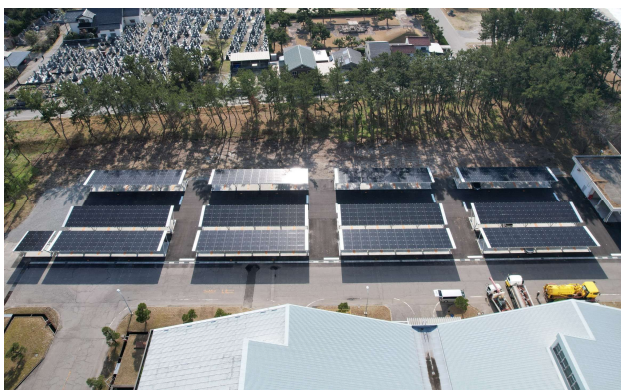
太陽光発電工事(カーポートタイプ)
