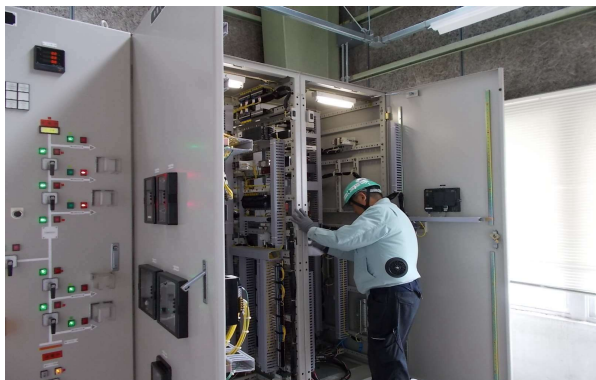
特高変電所 定期点検作業
