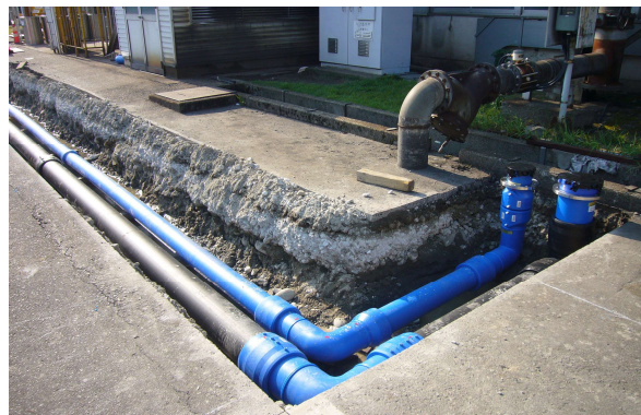
井戸メイン配管連結及び工業用水メイン配管更新
