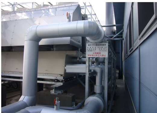
空調熱源改修工事
