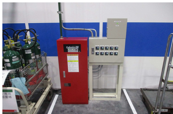
ダクト内自動消火設備設置工事
