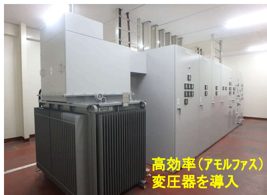
受変電設備更新(高効率変圧器導入)
