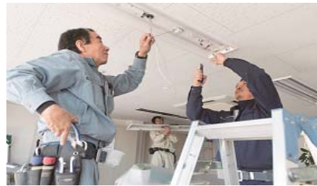
福岡本社 2012年12月 事務所と倉庫の蛍光灯を LED照明へ変更
