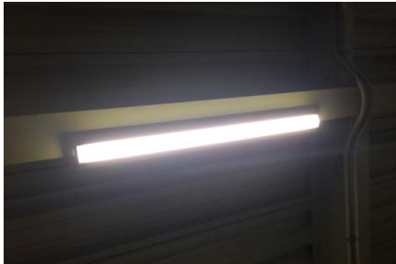
長崎事業所 2015年12月 倉庫の水銀灯をLED照明へ変更
