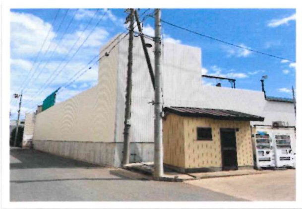
・八潮工場の外壁工事をしました。
