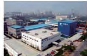
明電舎(鄭州)電気工程有限公司 [中国] MEIDEN ZHENGZHOU ELECTRIC CO., LTD.
