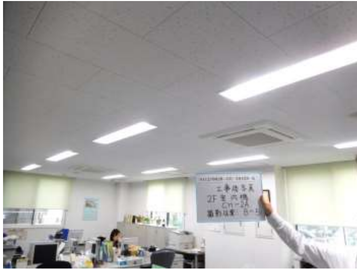
2階フロア 事務室
