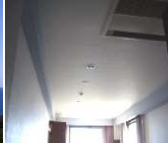
客室LED照明器具導入
