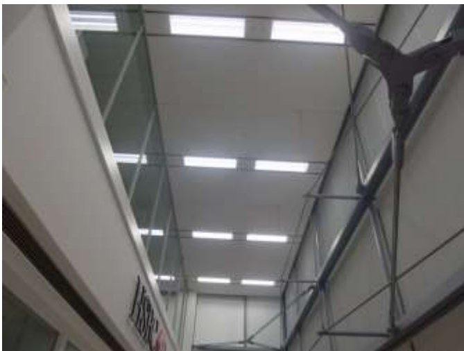
1階フロア共用エリア
