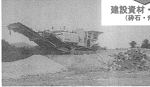
自走式破砕機 (グラウンド 造成工事)
