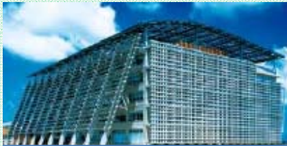
庁舎一面の太陽光発電
