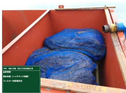
フィルターの設置
