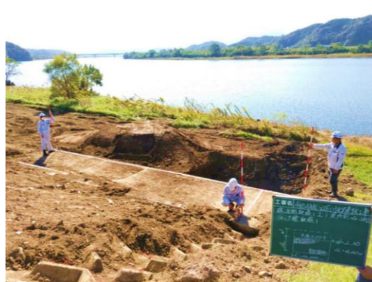
既設コンクリート取壊し寸法確認
