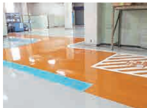
オフィス家具製造工場 塗床工事
