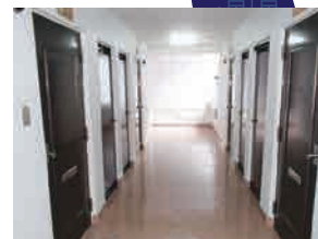
マンション共用部分改修工事
