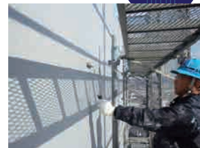
マンション外壁塗装工事
