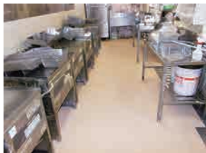
スーパーマーケット厨房 塗床工事
