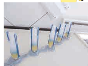
某駅前ビル 壁面クラック補修工事
