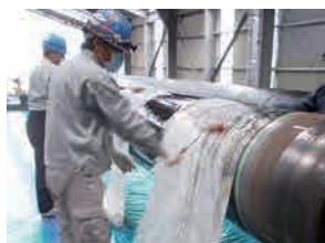
火力発電所地下坑 FRP ライニング工事
