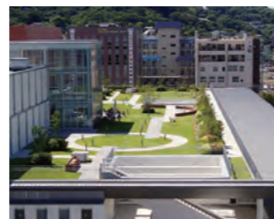
屋上緑化施工例 (ホルトホール大分)
