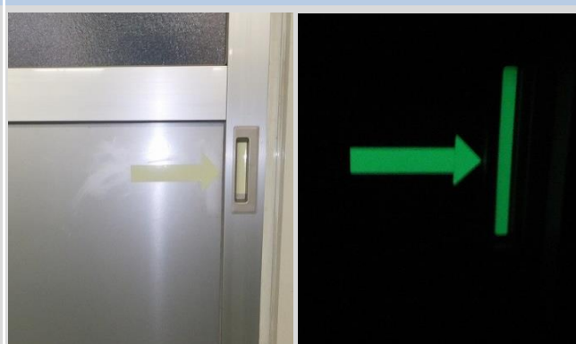
ドアの引き手部分（暗闇では開けにくくなる）
