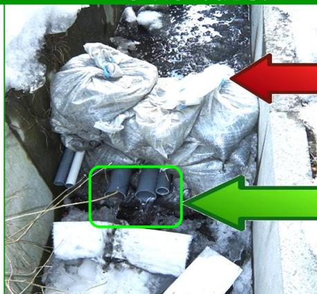
常備していた砂袋を3段に積み重ね、排水溝に流れ込む水（灯油含む）を堰き止める。
