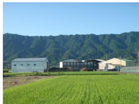
緑のリサイクルセンター (久留米市田主丸町)
