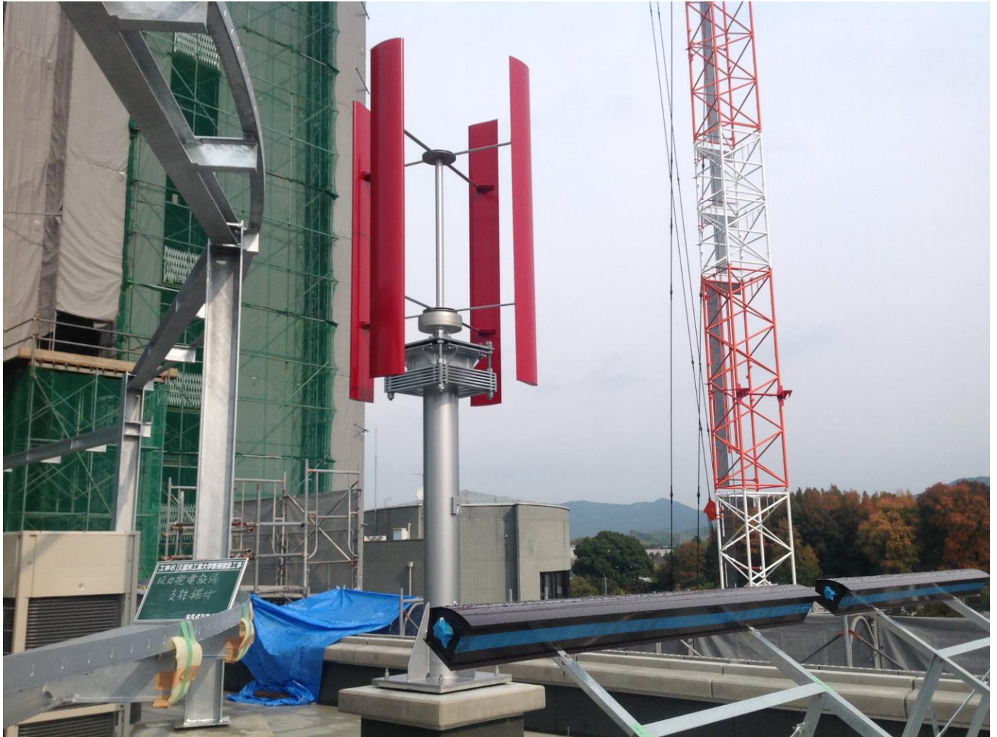
某工業大学 小型風力発電機（Kharos）設置工事
