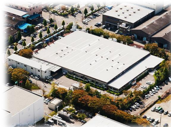
提携先の工場および事務所の屋根 約 5,000㎡ (塗布面積: 約 7,000㎡)
