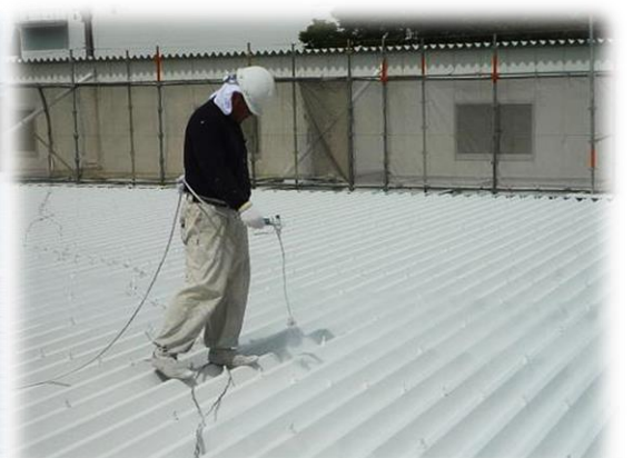
ガイナ吹き付けの様子 (2回塗りで塗膜厚800μ)
