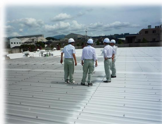
向かって左側がガイナ塗布前 塗布前の屋根は、素手でさわれない
