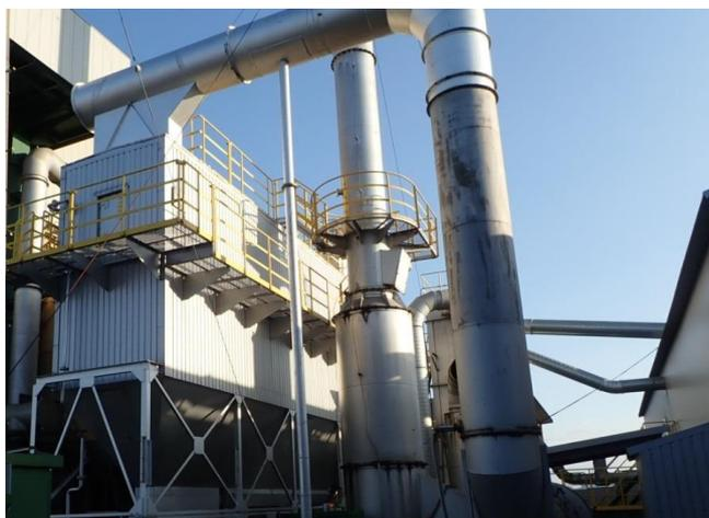
乾燥エリアのバクフィルター（集塵装置）整備状況
