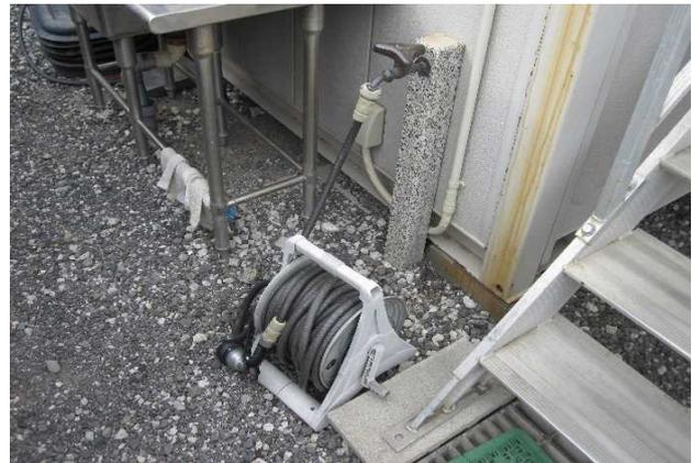
節水呼び掛け、ストップガン取付け
