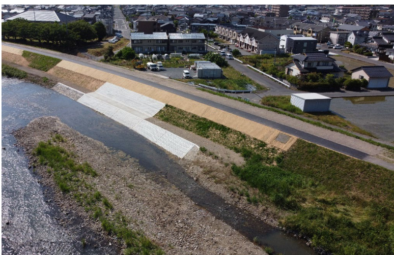
令和3年度千代川水系袋川乙堰撤去他工事
