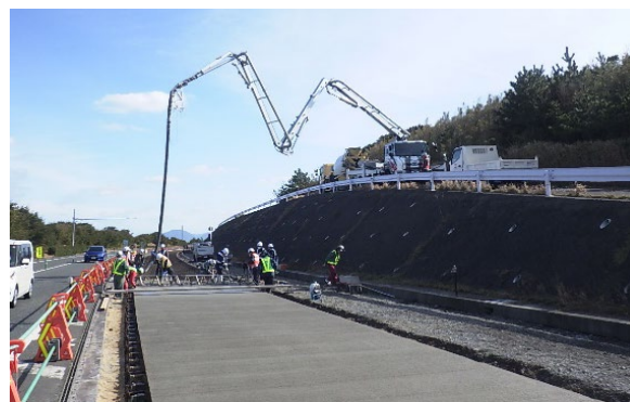
令和2年度国道9号伏野地区舗装修繕工事
