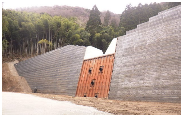
不動谷川砂防工事（堰堤工）
