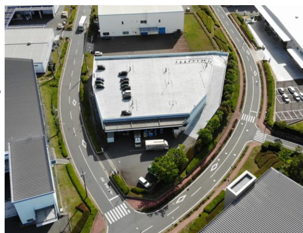
組立工場（小野市）
