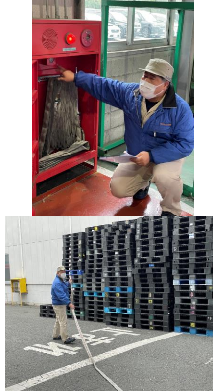
屋内消火栓の使用方法説明1
