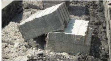
2. 泥土改良固化材Aの投入・攪拌
