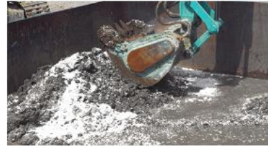
3. 固化材B（セメント）の投入・攪拌
