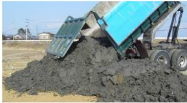
4. 改良土を仮置き・養生
