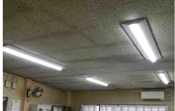
事務所の蛍光灯照明をLED化
