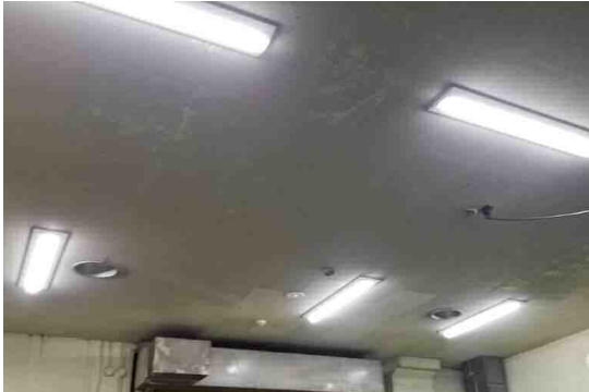
工場内の蛍光灯照明をLED化
