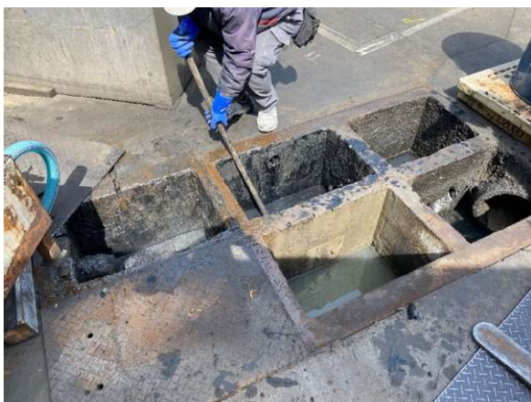
油水分離槽清掃
