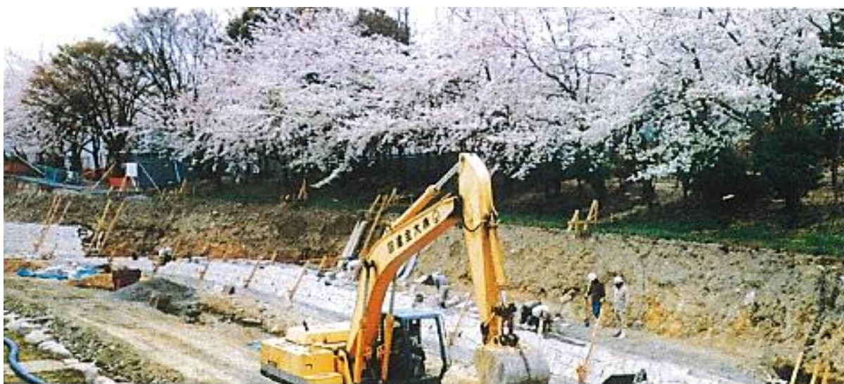
一級河川箕面川改修工事(西小路宮橋下流右岸)
